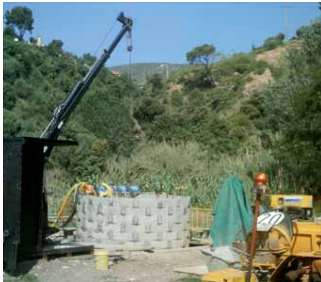
Nou Pou 4 de l'Etap, actualment en construcció
